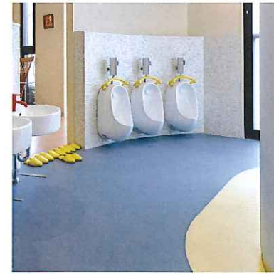
ビニル床シート： サンゲツ エスリュームプレーン
