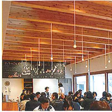
梁現し +オスモウッドワックス仕上げ
